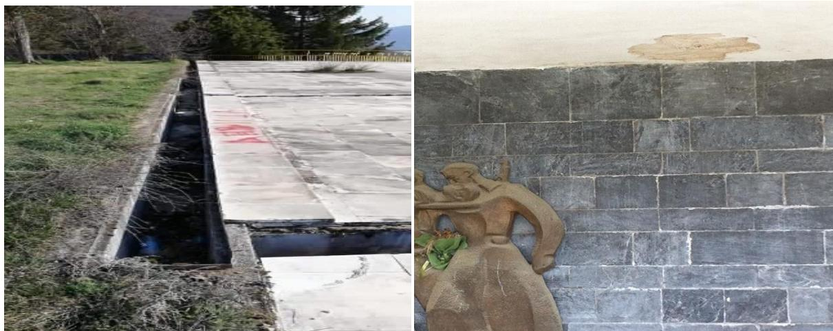
Слика 13 Одводен канал за атмосферски води
